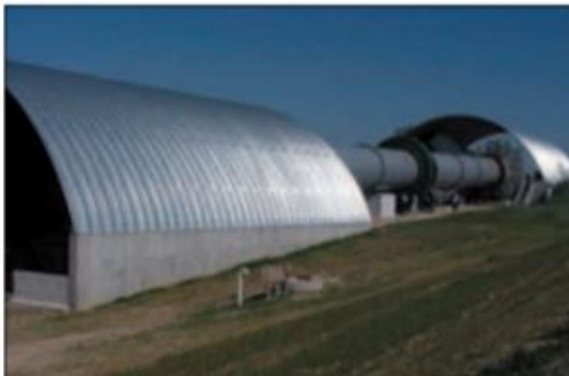
Slika 14. Bioreaktor na rotirajući vodoravni cilindar (Mondo Pulito).
