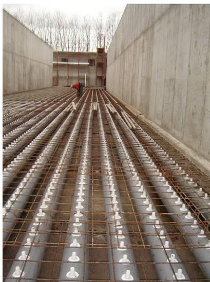
Slika 37. Sustav podnog prozračivanja s mlaznicama u izgradnji prije lijevanja betona (<http://www.christiaensgroup.com/waste-management-projects/bioman-spa>)
